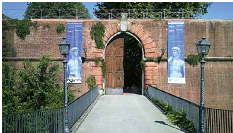
L'INGRESSO PER ACCEDERE ALLA FORTEZZA DA BASSO
